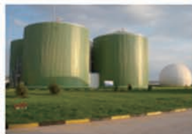
我国第一座 MW级CSTR沼气发电上网工程 蒙牛澳亚乳业牧场
