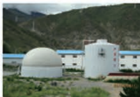
我国第一座 高海拔地区养殖场CSTR沼气工程 西藏拉萨
