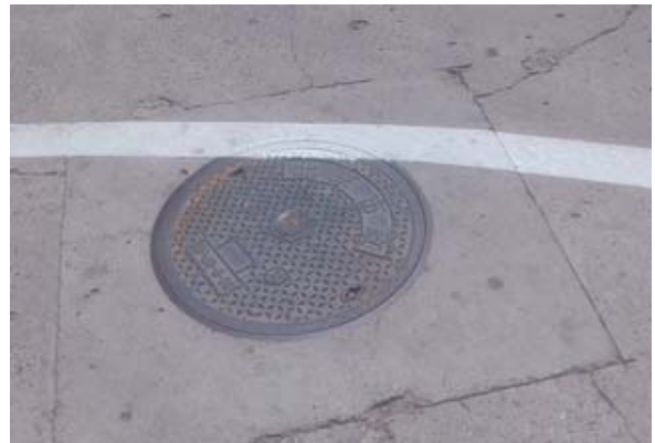
图 10 厂区污水总排口
