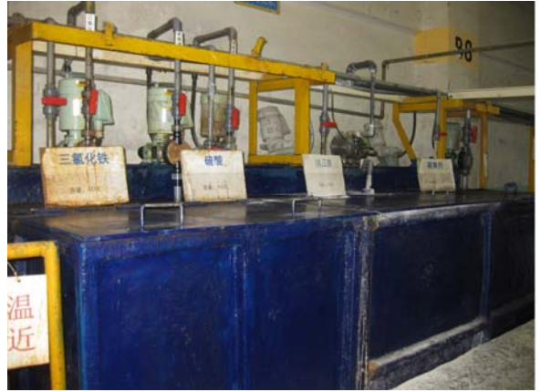
图 8 现有涂装废水处理车间
