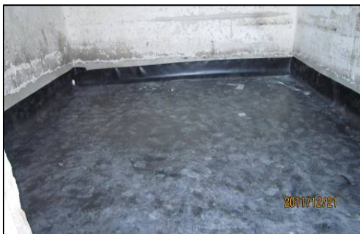
图 13 防渗层高密度聚乙烯土工膜铺设现场
