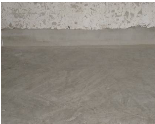
图 15 水泥硬化后的危废置场地面
