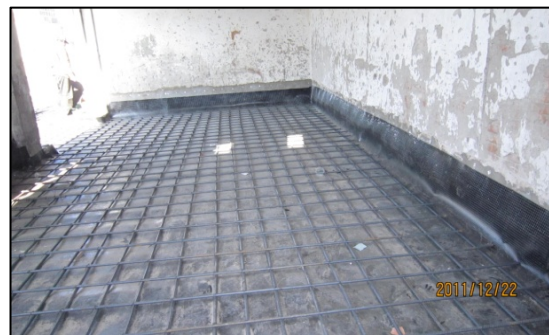
图 14 地面钢筋混凝土层钢筋铺设施工现场
