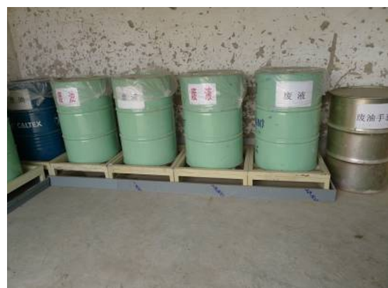
图 16 二次防渗铁槽及化学品安置现状
