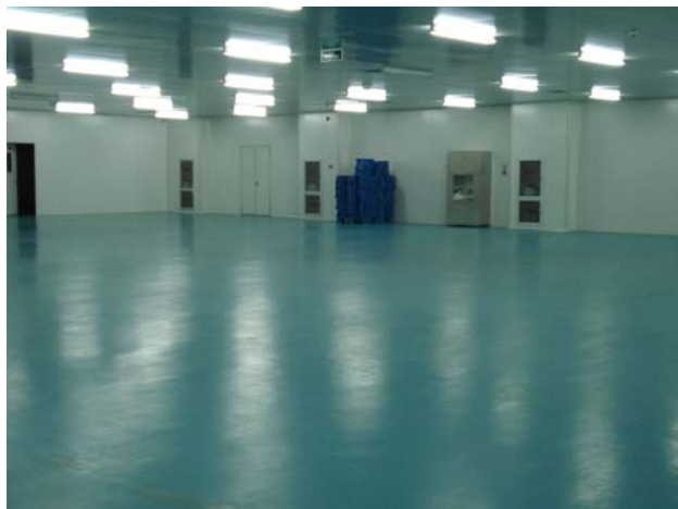
图7 本项目拟建场地现状
