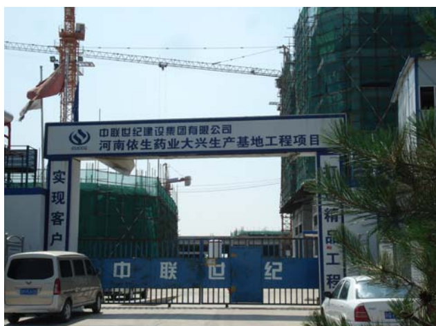
图8 民海生物北侧在建工程
