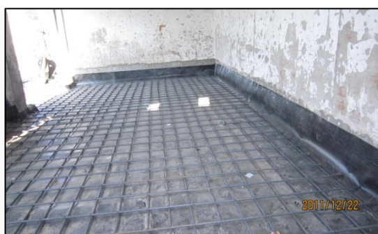
地面钢筋混凝土层钢筋铺设施工现场
