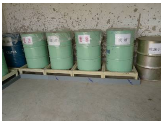
二次防渗铁槽及化学品安置现状
