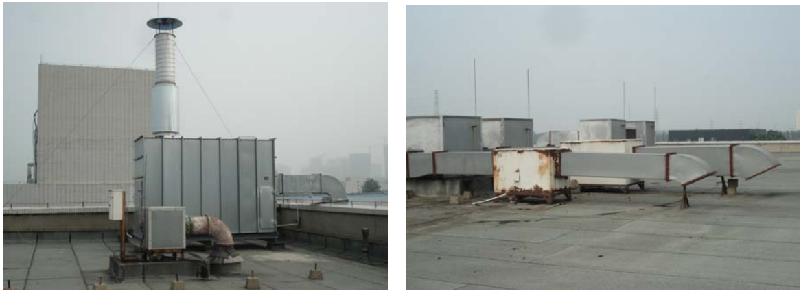
1#建筑物顶部挤出成型工段排气筒（排气口高 15m） 1#建筑物顶部食堂油烟废气排放口（排放口高 12m）
