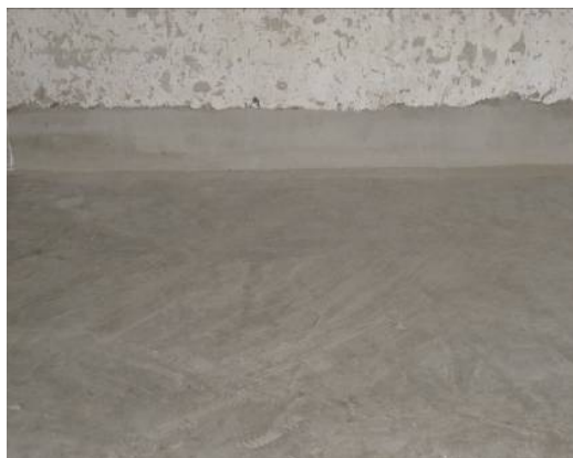
水泥硬化后的危废置场地面
