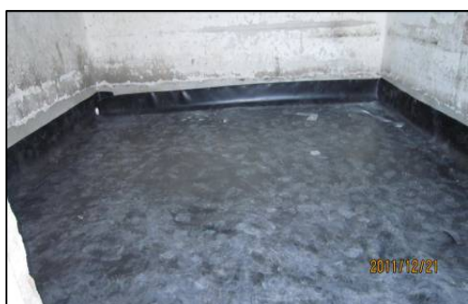
防渗层高密度聚乙烯土工膜铺设现场
