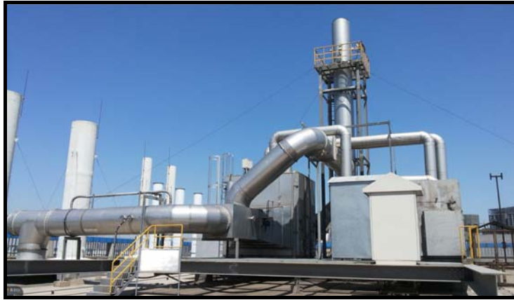
本项目所在地（B1C 厂房顶层露台）已有 VOC 处理装置及排气筒标志牌
