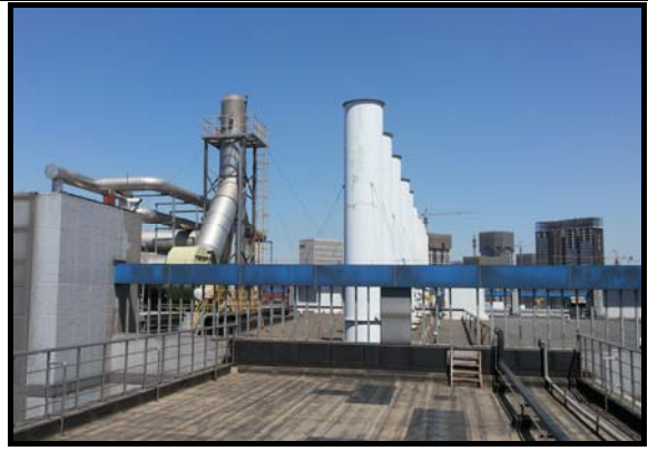
项目北侧（B1A 厂房顶层露台）
