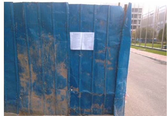
本项目施工场地外界
