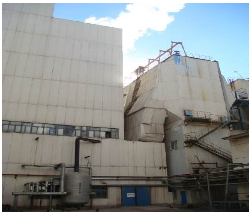
图 2-1 炉后烟道布置
