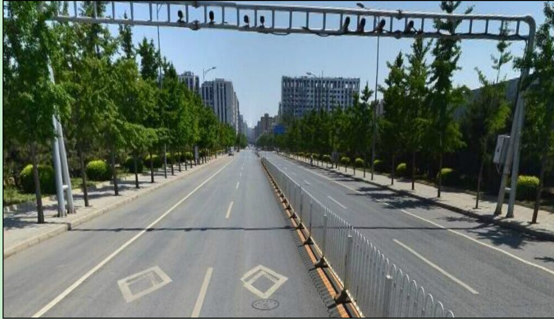
图3 项目相交道路实兴北街现状
