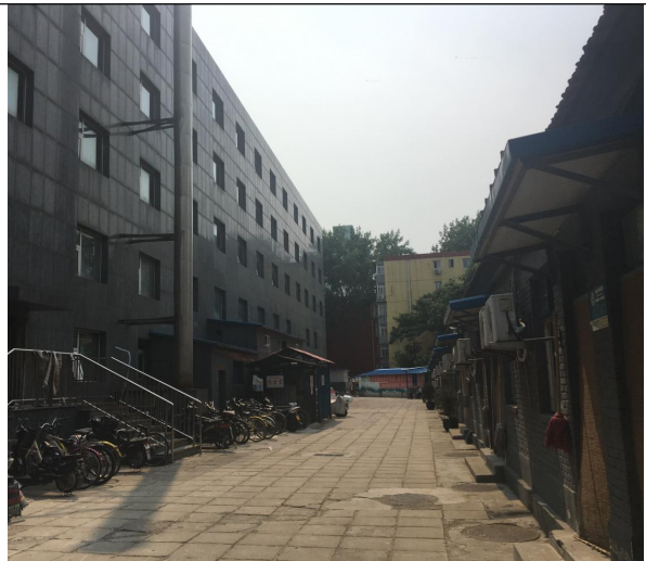
拟建项目所在建筑北侧
