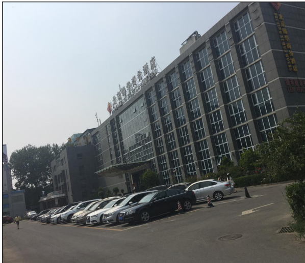
拟建项目所在建筑正南
