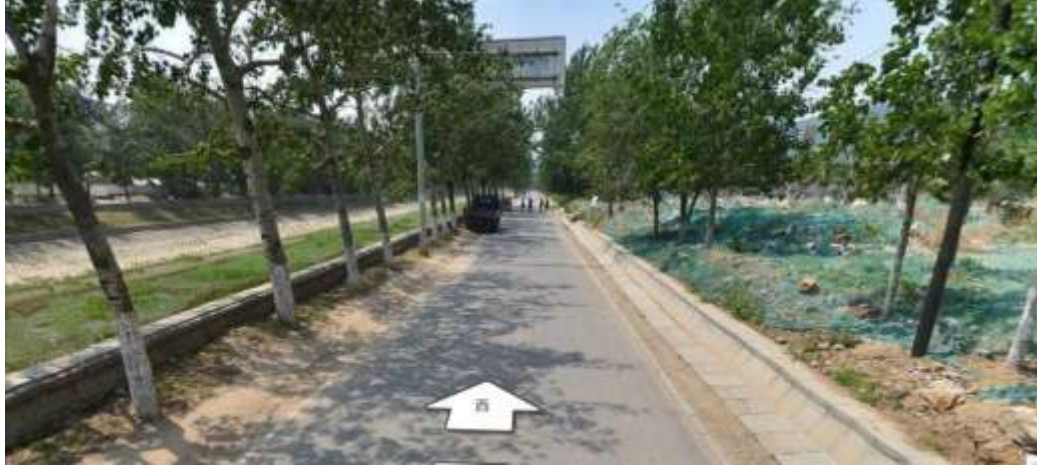
项目相交道路永引渠北路现状
