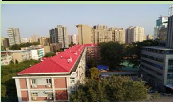
项目所在建筑东侧和平街十三区 20 号楼
