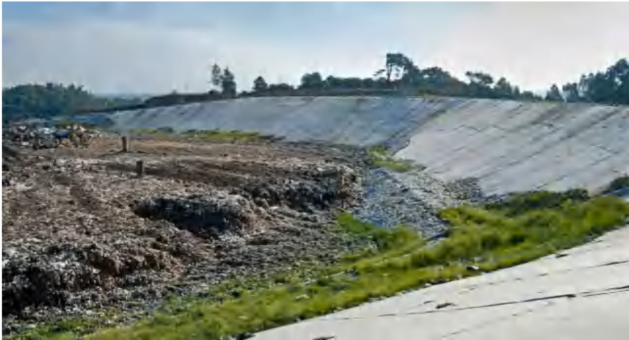
图 2-4. 国内某填埋场
