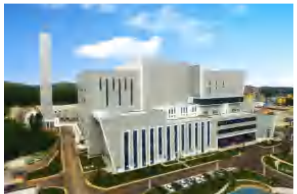
图 2-5. 国内某焚烧厂
