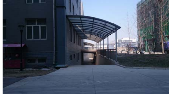
照片4 锅炉房入口
