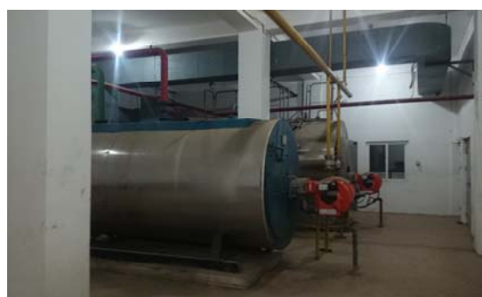
照片 2 锅炉安装现状
