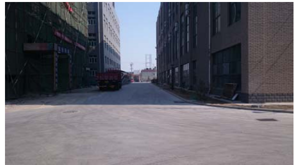
照片6 在建2号车间
