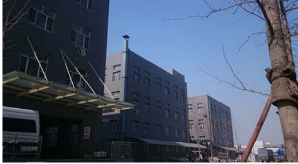
照片3 锅炉烟囱
