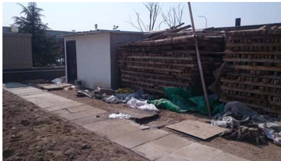
照片5 厂区污水处理站
